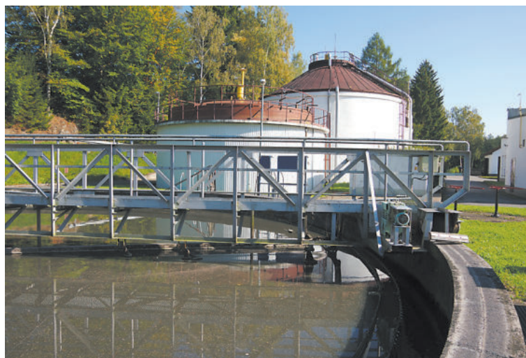
SOUČASNÝ stav ČOV. Plynojem a vyhnívací nádrž před rekonstrukcí.
