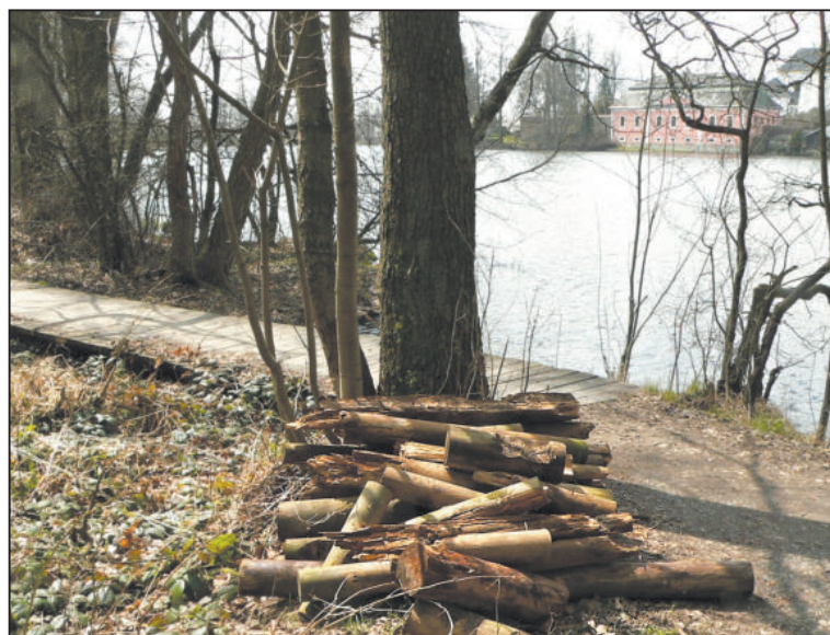
STAV naučné stezky krátce po převzetí zakázky, kdy firma začala vytrhávat ztrouchnivělé dřevo z chodníku.
