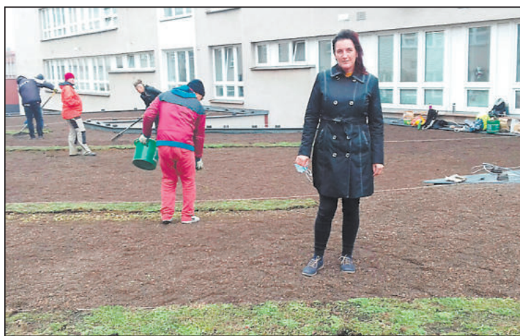
PRVNÍ zelenou střechu ve Žďáru měla loni poliklinika. Ozdobí ji netřesky a květy rozhodníků. V létě zelená střecha budovu příjemně ochladí a v zimě poskytuje tepelnou izolaci. Snímek ze zakládání zelené střechy. V popředí ředitelka polikliniky Ilona Komínková.
