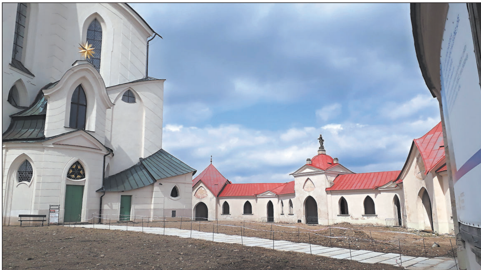
ZA ZDMI AMBITŮ na Zelené hoře je vidět kus práce. Restaurováný kostel se stále více přibližuje původní santiniovské podobě. Přes poutní loučku navede poutníky do chrámu bílá dlažba. Foto: Lenka Kopčáková
