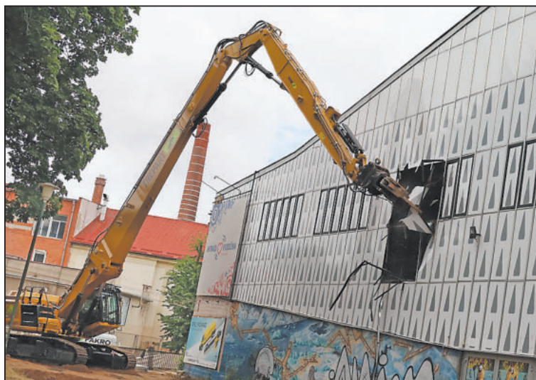
SYMBOLICKÉ zahájení demolic. Naplno začala 1. srpna. Foto: Petr Klukan
