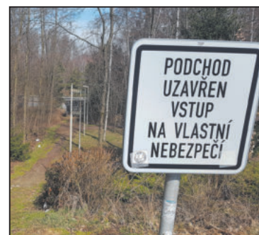
PODCHOD pod dálnicí je dlouhodobě uzavřen. 3x foto: autor
