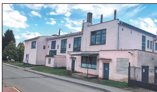
STÁVAJÍCÍ kotelnu dozná zásadní rekonstrukci.
