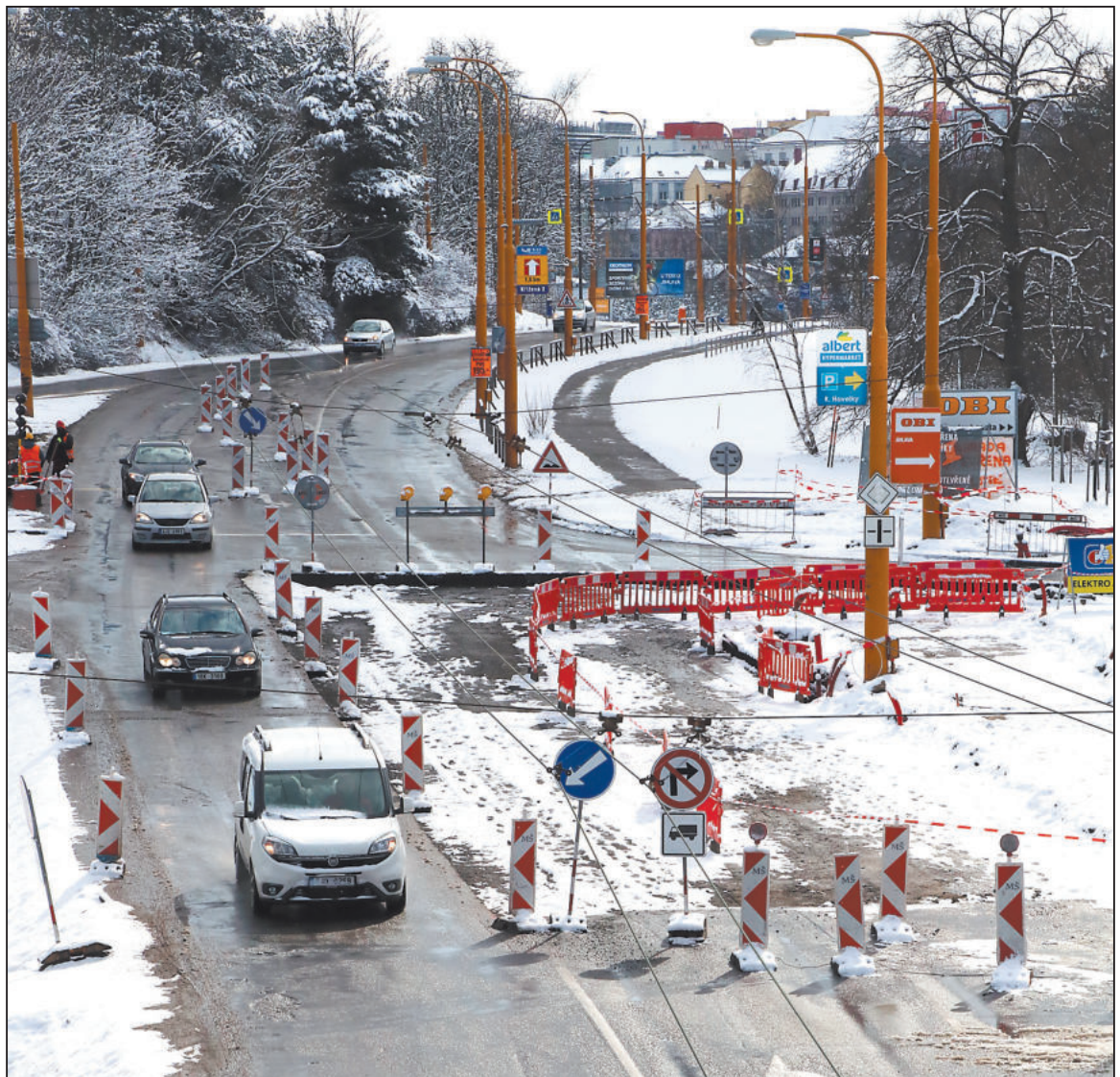
V TOMTO místě na ulici Romana Havelky se buduje nová světelná křižovatka. Stavební práce na křižovatce začaly ještě v době vydatných sněhových přeháněk. Od poloviny března se zde jezdí kyvadlově. Foto: Petr Klukan
