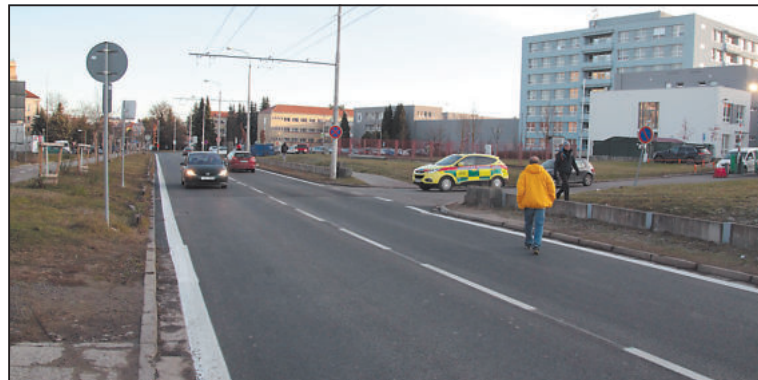
V ZÁPADNÍ části Vrchlického ulice je položen protihlukový asfalt. Foto: Lubomír Maštera
