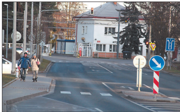
NA ULICI S. K. Neumanna je opraven úsek s již dříve položeným protihlukovým asfaltem i s podložím. Foto: Lubomír Maštera
