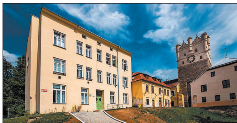
JIHLAVA vlastní 747 nájemních bytů a 409 bytů v bytových družstvech. Opravený nájemní dům v ulici Matky Boží 36 ve vlastnictví města. Foto: archiv MMJ
