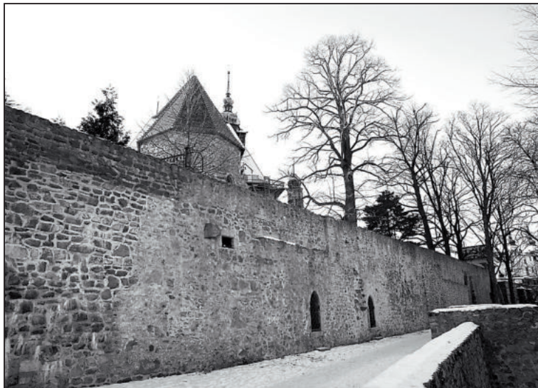
KAPLE V červnu roku 1646 dal Plukovník Oesterling zbořit při opevňovacích pracích za kostelem sv. Jakuba i českou kapli sv. Václava. Pozůstatky základů zbořené kaple lze spatřit z hradebního parkánu pod kostelem.
