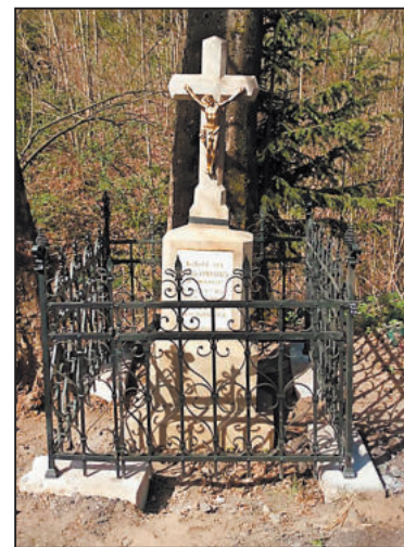
KŘÍŽEK v Henčově restauroval Otakar Marcina a celková oprava město stála necelých 60 tisíc korun.
