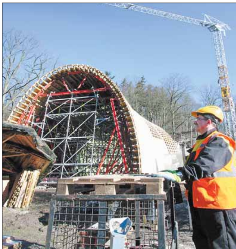
JIHLAVSKÉ ZOO již delší dobu dominuje výškový jeřáb a pod ním probíhající stavební činnost. Projekt Zoo pěti pavilonů vstupuje do své finální fáze, a tak se nedá ani mluvit o zimním klidu, nehledě na nezvyklé jarní počasí.
