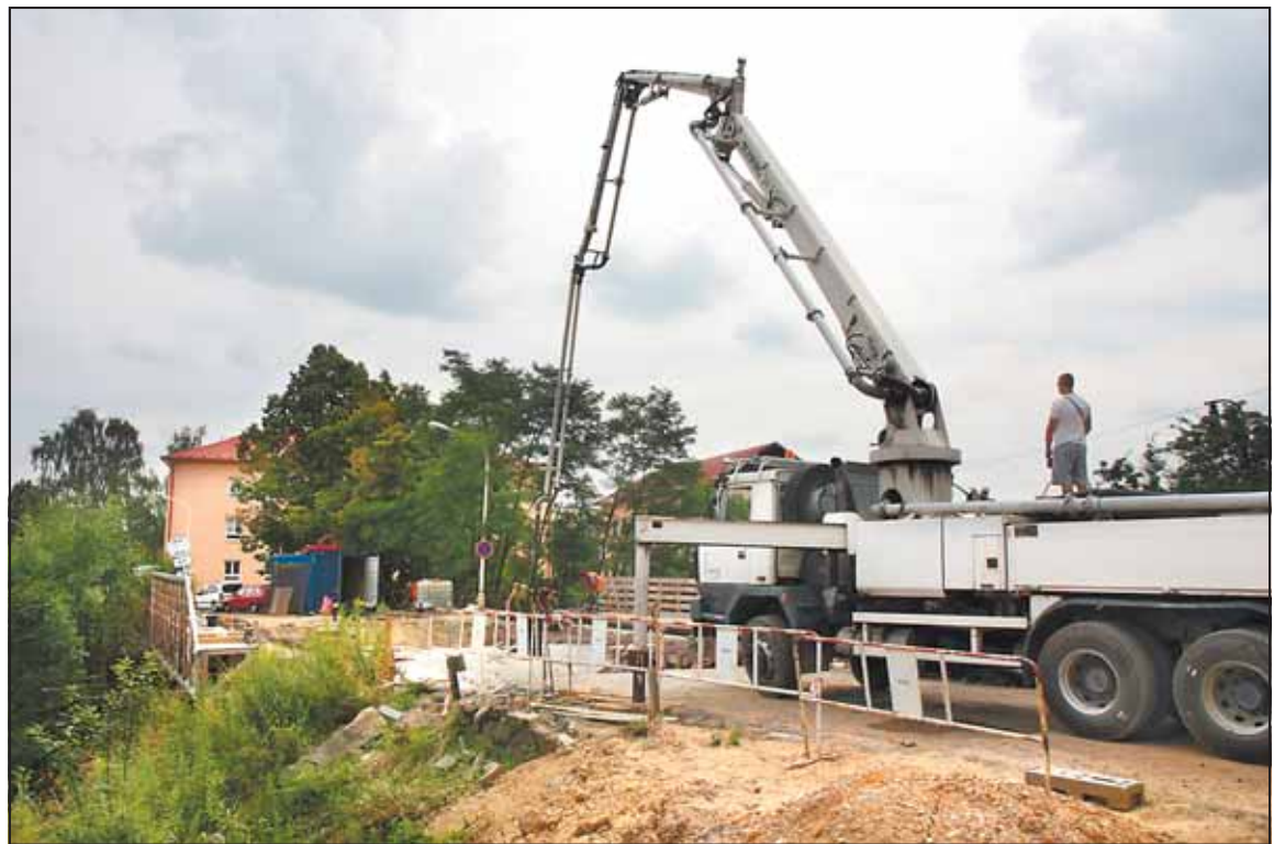
V JIHLAVĚ se revitalizuje, rekonstruuje, opravuje a staví jako nikdy dříve. Občanům to přináší hluk stavebních strojů, prašnost a další omezení, ale také upravená sídliště, parky, komunikace ad. Dopravu ve městě zasáhla oprava několika mostů. Na snímku těžká technika při opravě železničního mostu u Kronspanu. Foto: Lubomír Maštera
