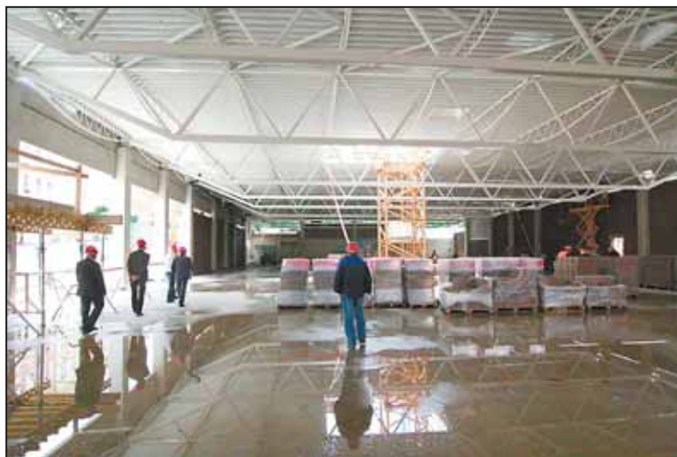
S MĚSÍČNÍM předstihem probíhá výstavba jihlavského „zimáčku“. Hrubá stavba je u konce, objekt je pod střechou. Toto zjištění potvrdil kontrolní den na stavbě. Foto: archiv MMJ
