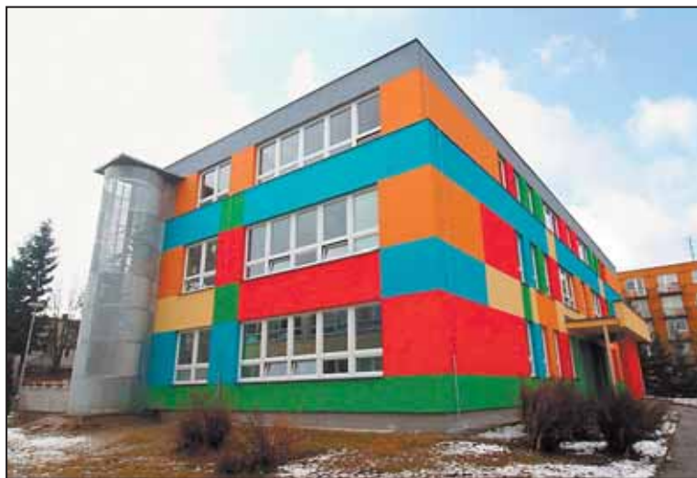
MŠ V JARNÍ ULICI. Jihlava otevřela rozšířenou a opravenou mateřskou školu Mozaika v Jarní ulici. Dvoupodlažní budově přibýlo další jedno podlaží o dvou třídách, nově je vybudována výdejna stravy, sociální zařízení a zázemí pro personál.
