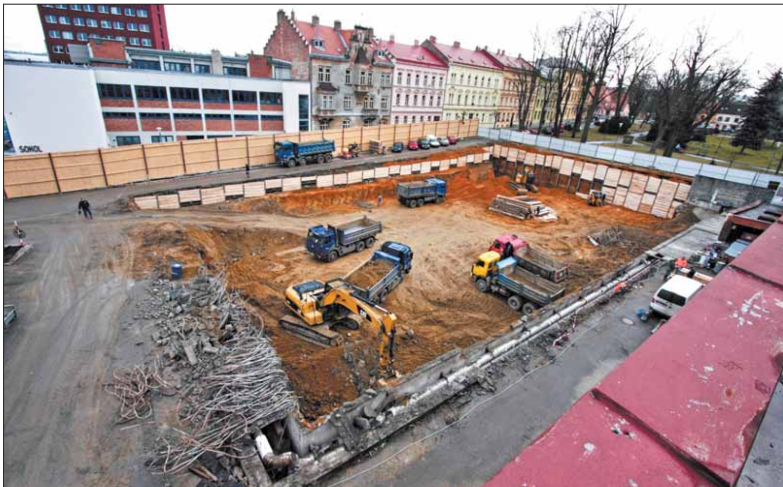
MÍSTO venkovní plochy HZS je nyní obrovská díra do země.
