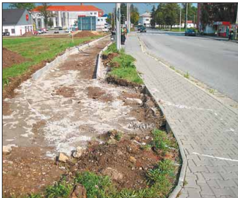
CYKLOSTEZKA NA DOLECH. Na ulici S. K. Neumanna Na Dolech v těchto dnech probíhá výstavba další části cyklostezky, protkávající Jihlavu k potěšení milovníků kol a in-line bruslí. Foto: Jiří Šimůnek
