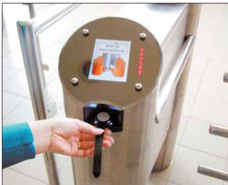
KRYTÁ ČÁST Vodního ráje je vybavena novými vstupními turnikety.
