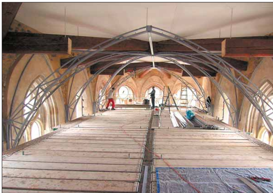
ODBORNÁ firma obnovuje v kostele Povýšení sv. Kříže klenby v presbytáři z pnuté fólie v rozsahu původní klenby.
