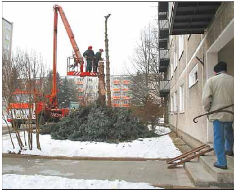
NA SÍDLIŠTI U Pivovaru probíhá probírka a kácení nevhodných a poškozených stromů a keřů.
