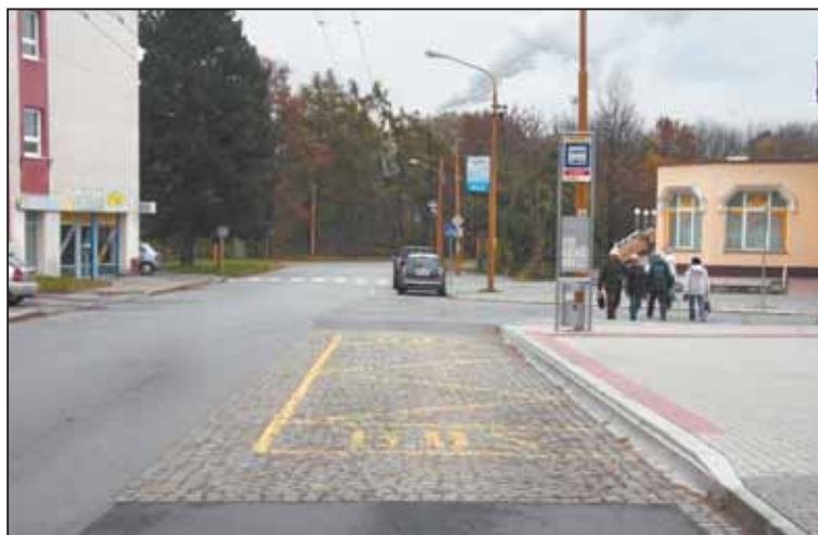
NOVÉ zastávky MHD v Jihlavě umožňují zastavovat těsně u obrubníku, zpevněné podloží má zabránit vyjíždění kolejí. Foto: Lubomír Maštera
