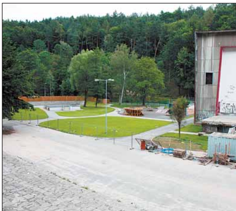
UŽITKOVÁ plocha vlevo od letního kina ještě čeká na dokončení...
