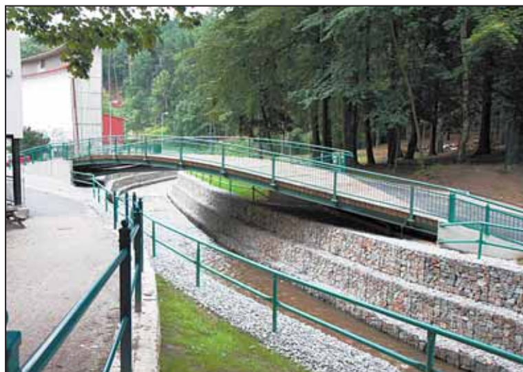
KORYTO potoka bylo zpevněno, zvýšila se možnost absorbovat náplavovou vodu a bylo přemostěno nově navýšenou prohnutou lávkou, která navazuje na asfaltovou příjezdovou komunikaci.
