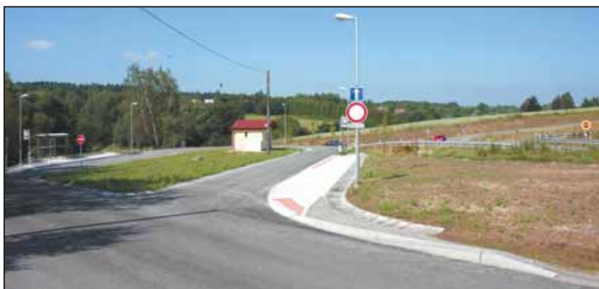
KONEČNÁ autobusové zastávky v lokalitě Ráj prošla rekonstrukcí. Vznikla zde točna a zázemí pro řidiče.
