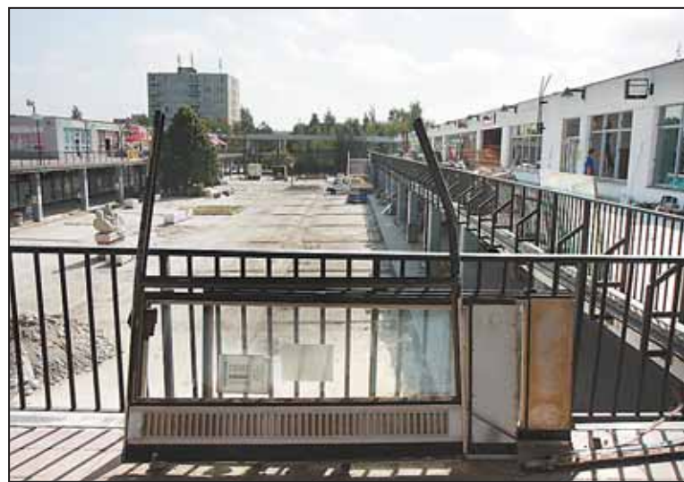
NA BŘEZINKÁCH ROZKOPÁNO. Obchodní středisko na sídlišti Březinova je rozkopáno. Důvodem je oprava chodníků a výstavba nové dlažby. Současně jsou prováděny rekonstrukce prodejních prostor v prvním patře.
