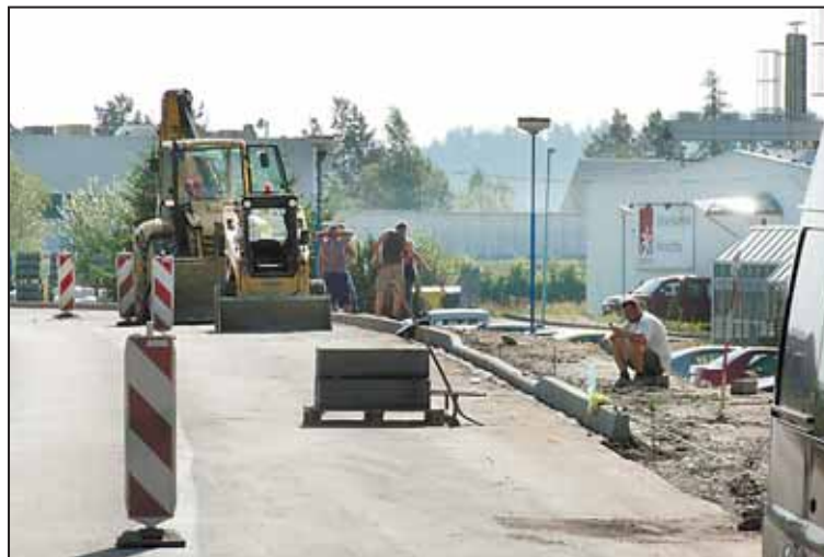
CHODNÍK, ZASTÁVKY MHD a veřejné osvětlení vznikne u silnice do Červeného Kříže. Foto: Lubomír Maštera
