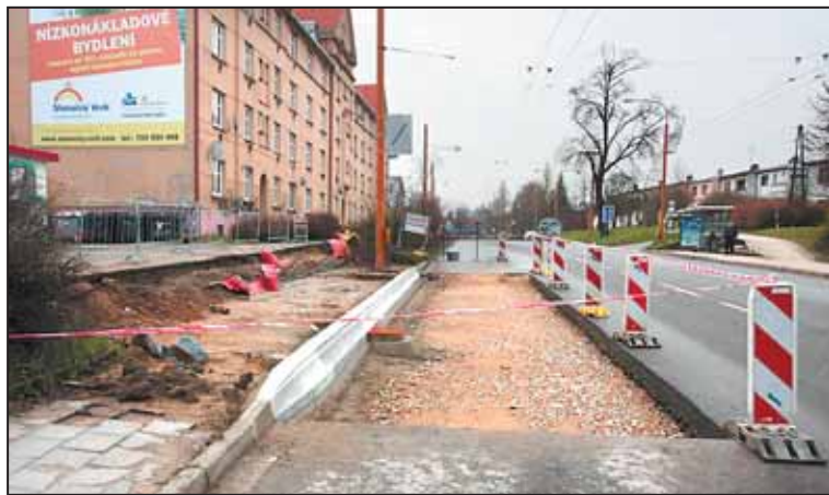
NA JIRÁSKOVĚ ulici již začaly bezbariérové úpravy zastávek MHD.
