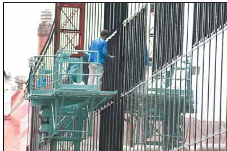
REKONSTRUKCE HZS. Horácký zimní stadion přestal ohrožovat kolemjdoucí. V minulých dnech proběhla tolik potřebná oprava jižní prosklené stěny, která vlivem opotřebení hrozila pádem skleněných tabulí.
