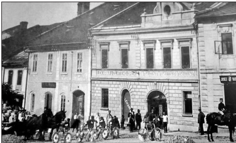
LÉKÁRNA U Zlatého orla, chráněná kulturní památka. Padla s demolicí východní strany náměstí. Zdroj: Žďárský uličník M. Lopaura
