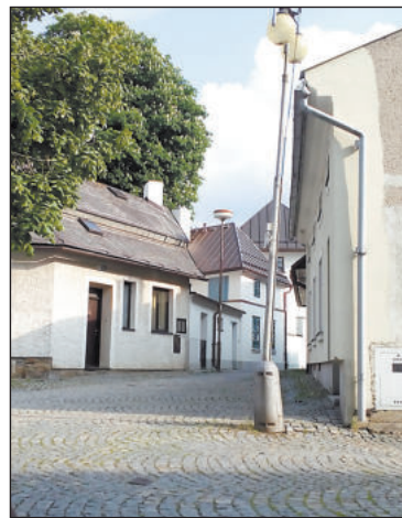
OKOLÍ Tvrze potřebuje opravit.
