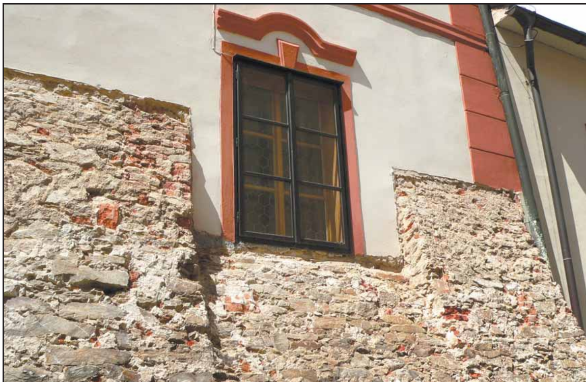
TAK VYPADALA při červnových oslavách města boční stěna Staré radnice. Zrovna procházela rekonstrukcí.
