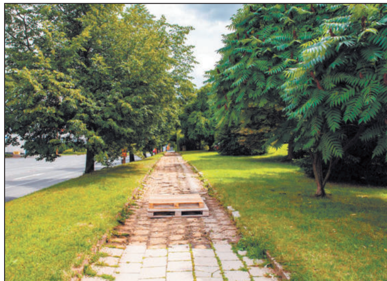
REKONSTRUKCE chodníku na ulici Jiráskova počítá se zadržováním vody v krajině. Foto: archiv MMJ
