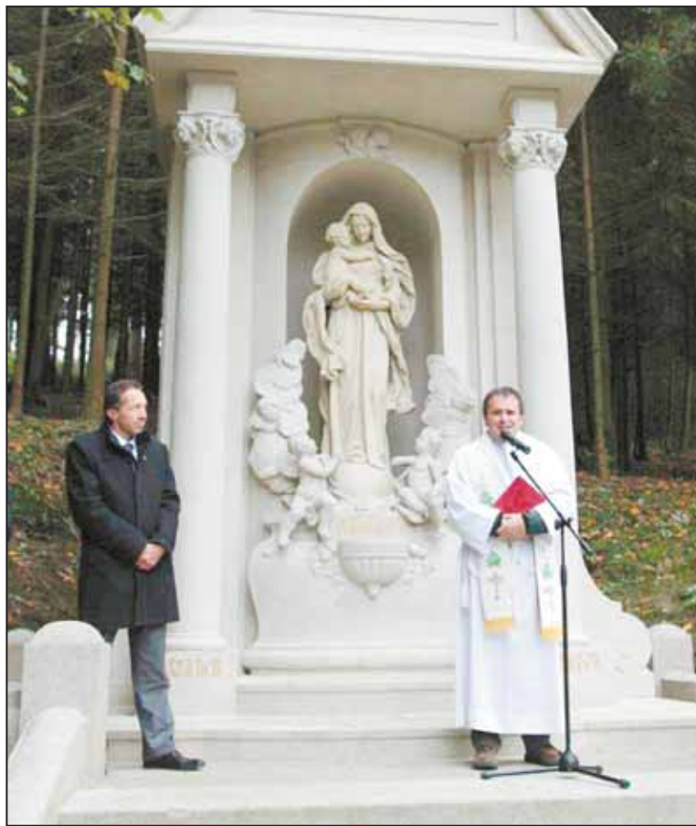
KAPLIČKA v Heleníně se v péči restaurátorů proměnila. Původně špinavý a počmáraný objekt je vyčištěný a ošetřený proti povětrnostním vlivům, zničené sochy Panny Marie s Ježíškem a andělů jsou opět kompletní, rozpadlé schodiště je zpět na svém místě, opravena je i masivní lavice z kamení a dřeva. Práce prováděl restaurátor Otakar Marcin se spolupracovníky. Celkově přišla oprava kapličky jihlavskou radnicí asi na 750 tisíc korun. Foto: archiv MMJ
